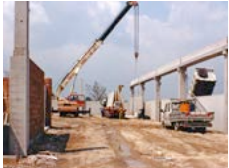
Inizio lavori nuova fabbrica
