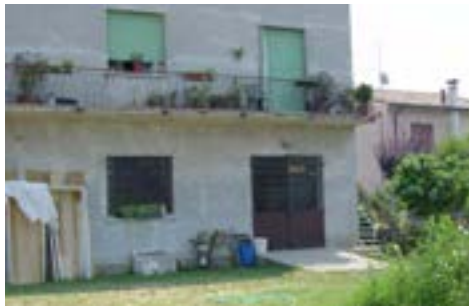
Sede di Via Caltrane
